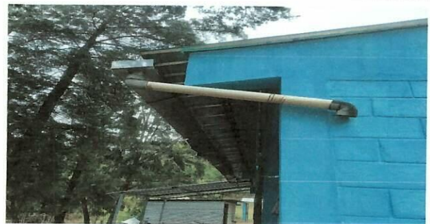
Foto 6: Remozamiento de canales y bajadas de agua pluvial
