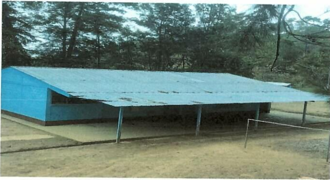
Foto 1: mejoramiento e instalación de estructura metálica y cubierta de lámina troquelada calibre 26 en módulos y corredor
