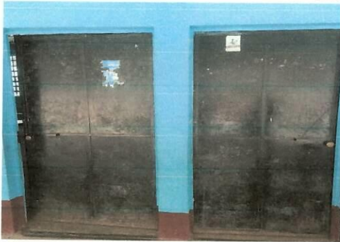
Foto 3: Remozamiento puertas metalicas
