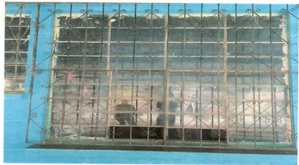
Foto 4: Remozamiento ventanas metálicas
