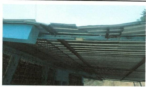
Foto 2: mejoramiento e instalacion de estructura metalica y cubierta de lámina troquelada calibre 26 en módulos y corredor
